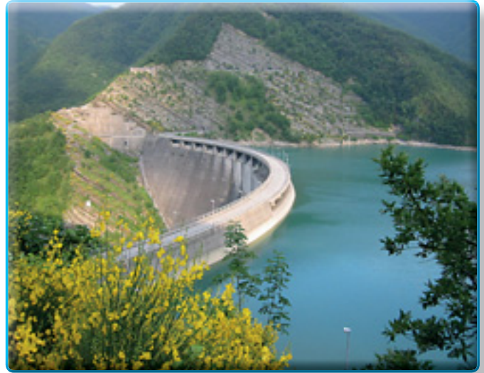
La diga di RIDRACOLI , nel Comune di Bagno di Romagna
