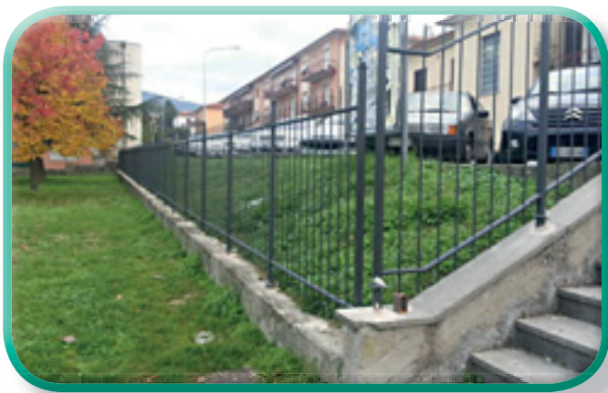
La recinzione apposta sul lato di via XXV Aprile
