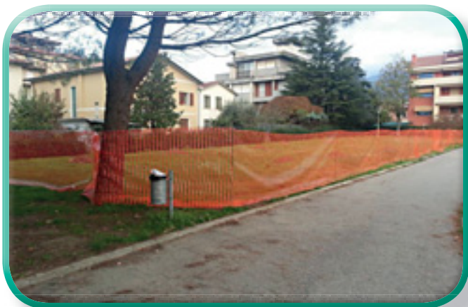
La parte centrale dei giardini, transennata per i lavori
