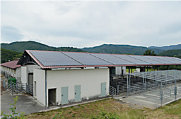
Il Centro Fiera Bestiame "Silvio Datti" con la nuova copertura in fotovoltaico
