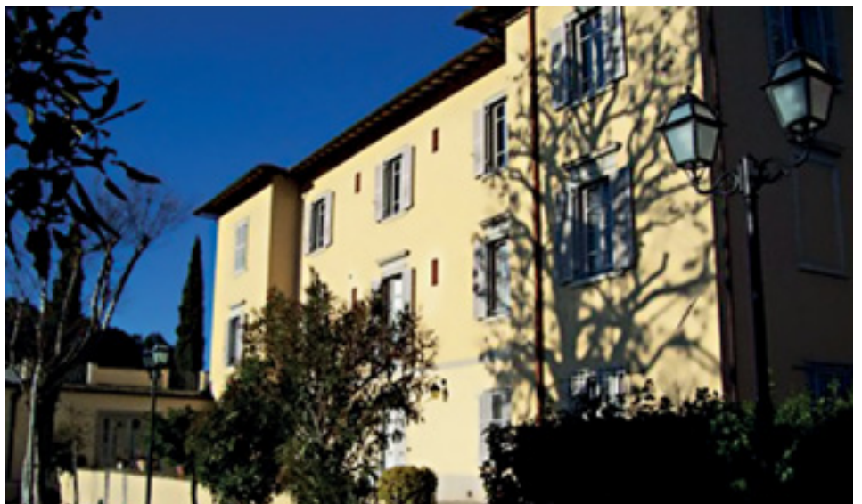
Particolare della facciata di Villa Serena
