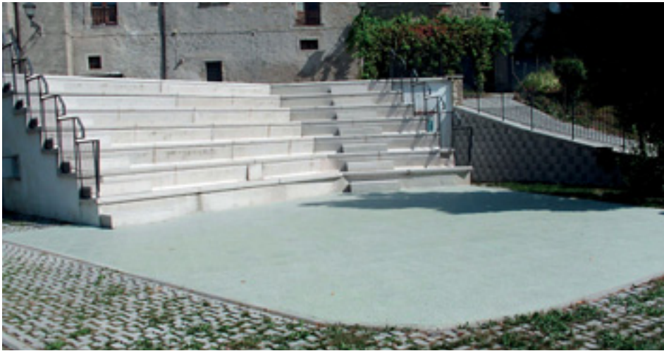
La scalinata in pietra che conduce al parco giochi per bambini di Sestino
