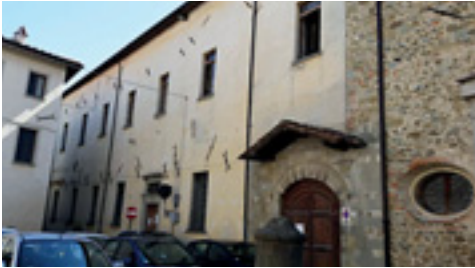
L'ex convento di Santa Chiara, sede storica della scuola elementare "Edmondo De Amicis"
