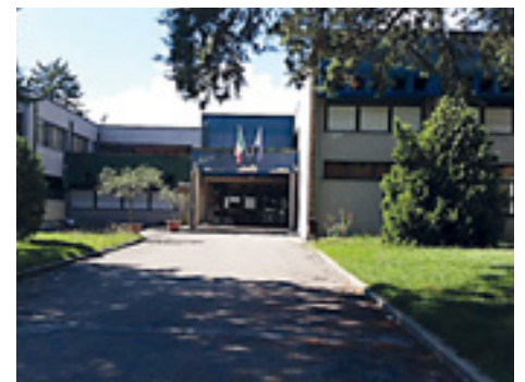
L'edificio della scuola media unificata
