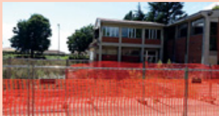
Il cantiere della nuova Collodi al Campaccio
