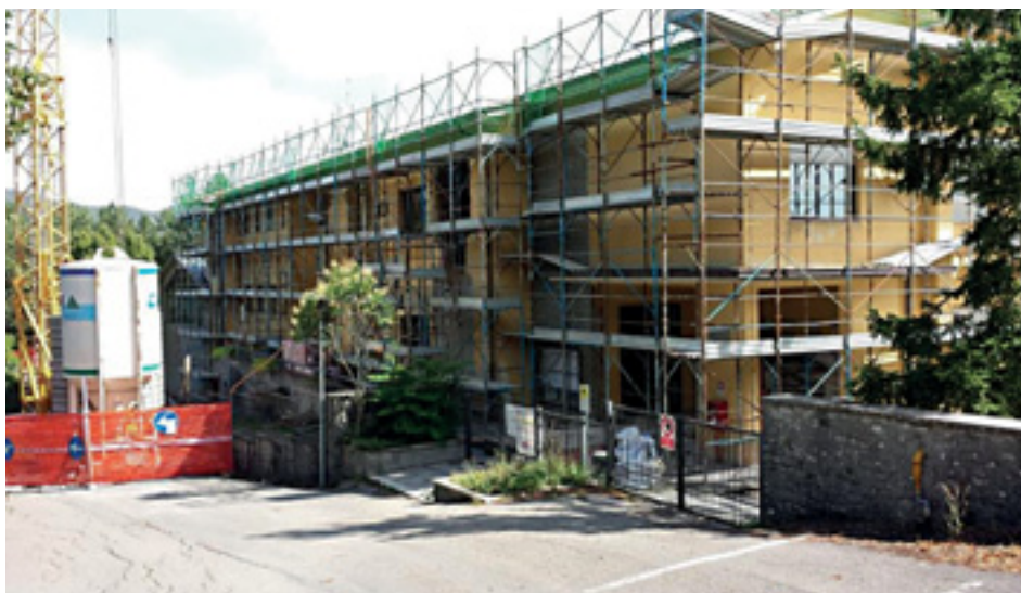
L'edificio della scuola elementare e media di Caprese coperto dai ponteggi
