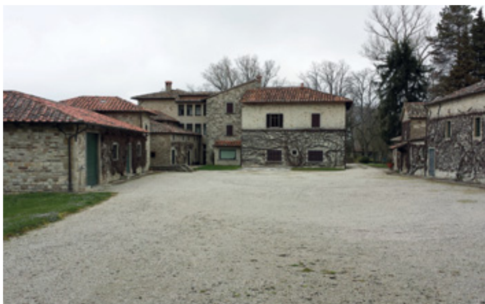
Il complesso della fattoria di Castelnuovo vista dal retro
