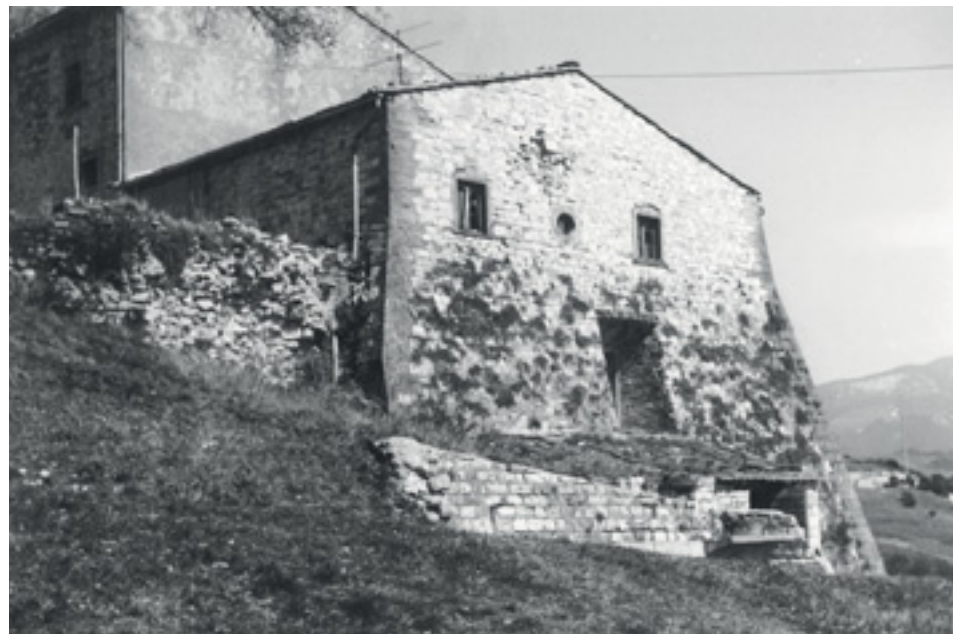
La fortezza di Castelnuovo
