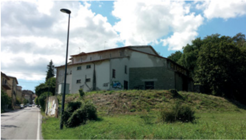
L'edificio dell'ex cinema Mondani, posizionato lungo la Ruga di San Martino
