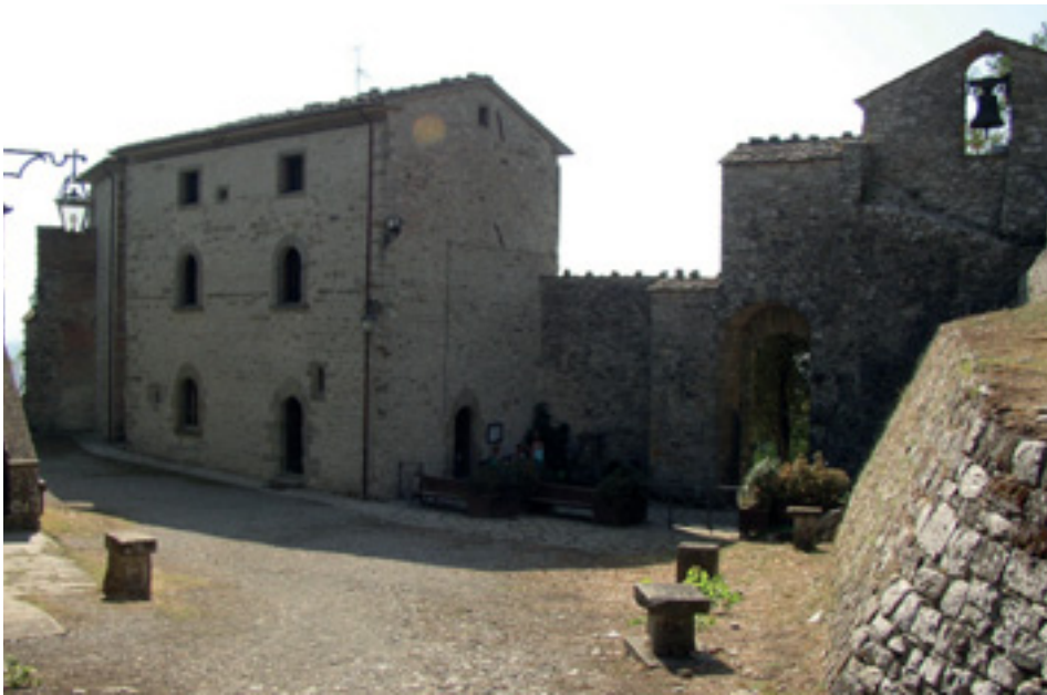
Veduta di Palazzo Clusini, all'interno del Castello di Caprese Michelangelo
