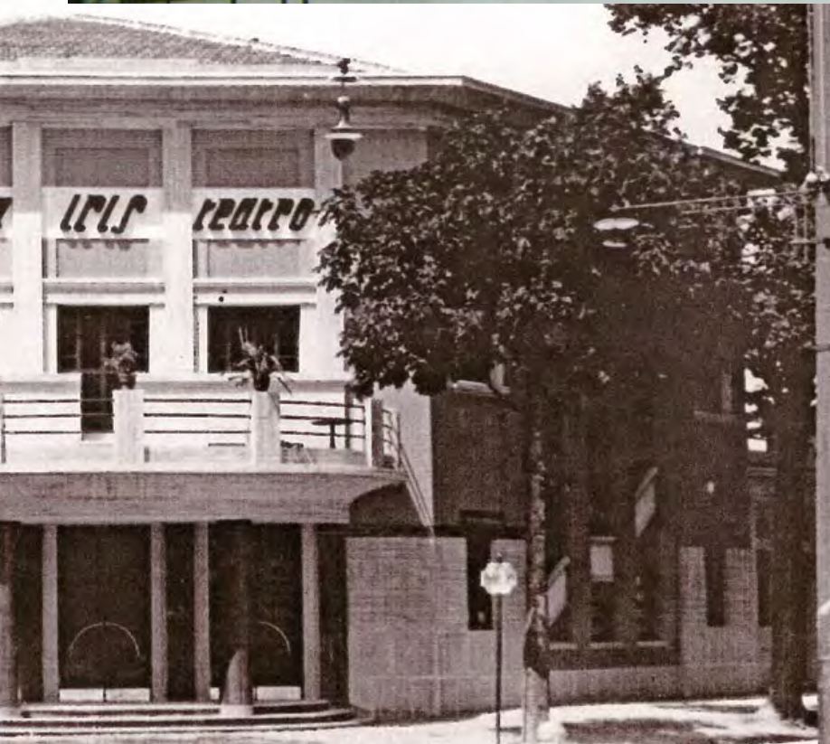
La facciata dell'Iris dopo la ricostruzione e fino alla demolizione
