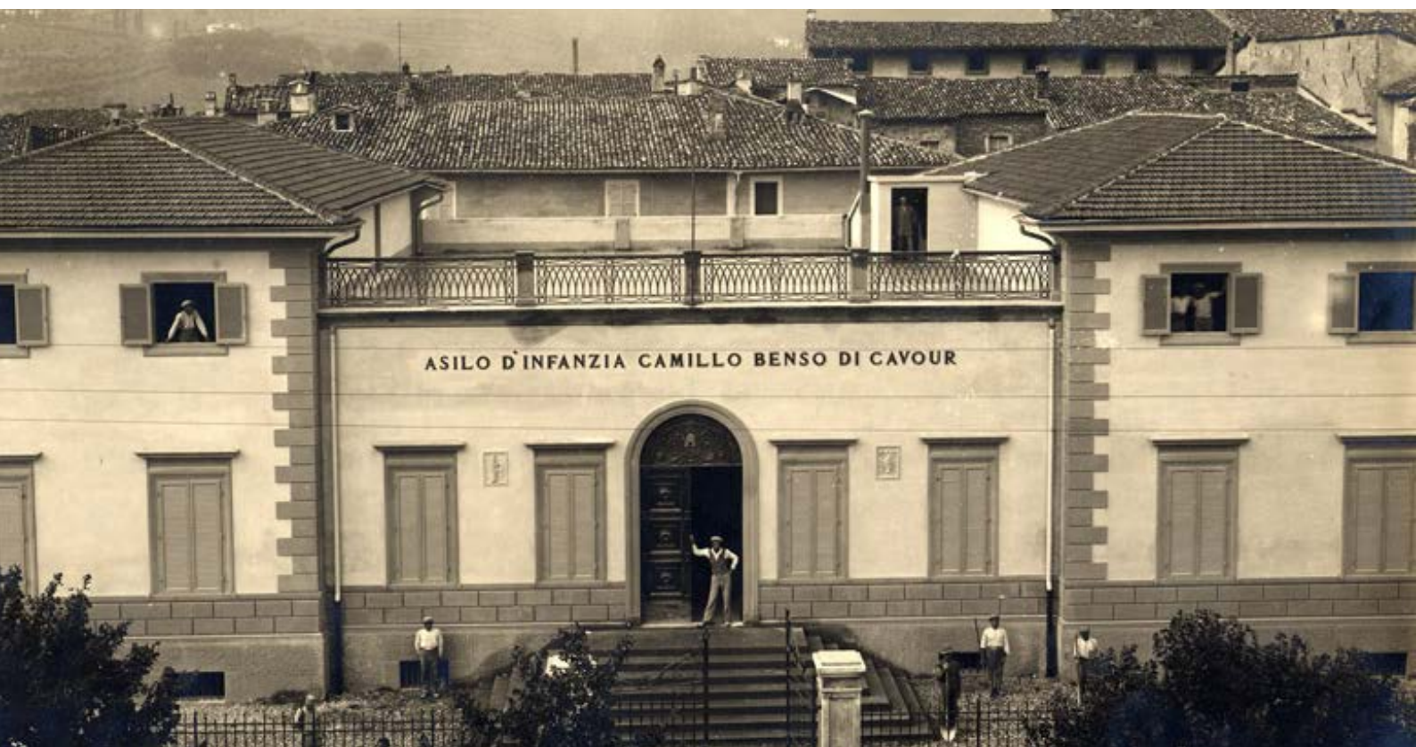
L'asilo di infanzia Cavour, primo grande impegno della Cassa di Risparmio
