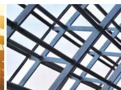
STRUTTURE IN ACCIAIO
