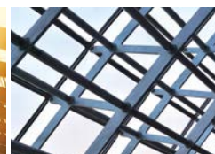
STRUTTURE IN ACCIAIO
