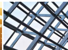
STRUTTURE IN ACCIAIO
