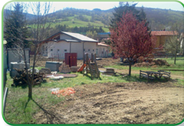
La SCUOLA MATERNA di Pieve Santo Stefano in fase di ampliamento
