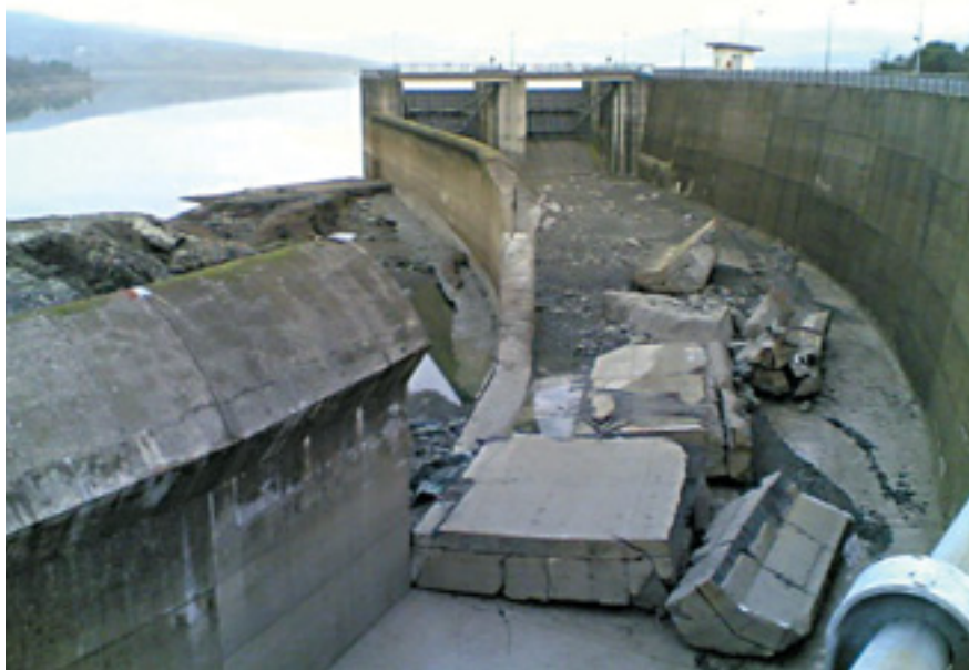
La parte del muro di sfioro della diga di Montedoglio che ha ceduto la sera del 29 dicembre 2010
