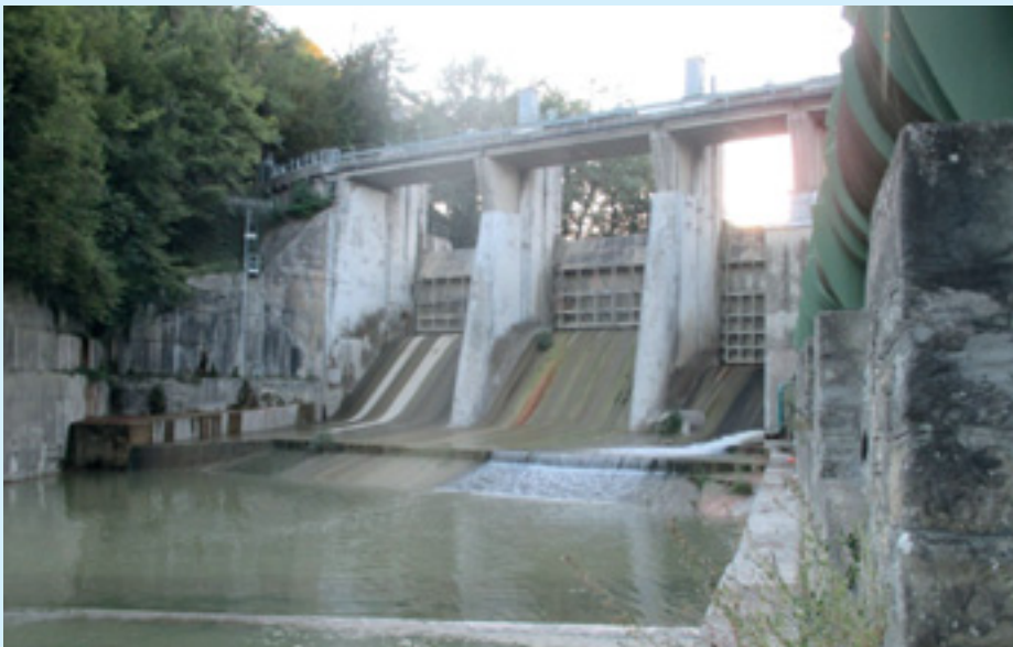
Le chiusure idrauliche in metallo del Lago di Quarto
