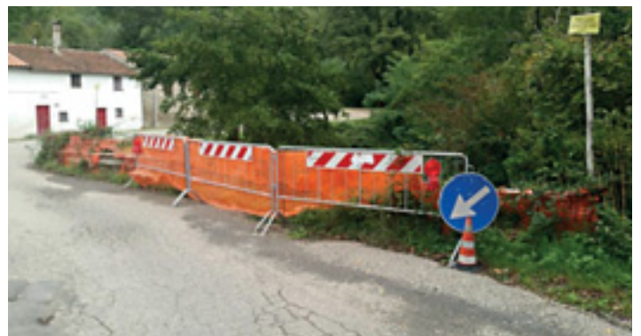
Il ponte sulla "esse" in località Le Tovagliole nel punto in cui si è verificato l'incidente stradale del dicembre 2014
