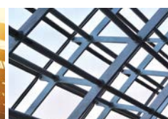
STRUTTURE IN ACCIAIO
